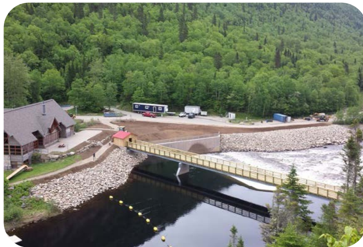
Le barrage des Érables - Source: Sépaq
